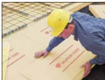
Perimeterdämmung unter lastabtragenden Bodenplatten
