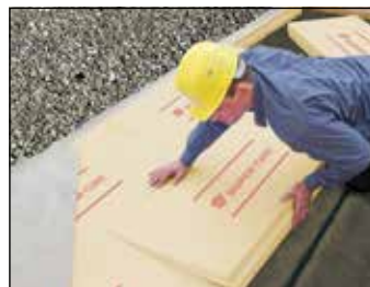
Neubau und Sanierung von Flach- und Umkehrdächern
