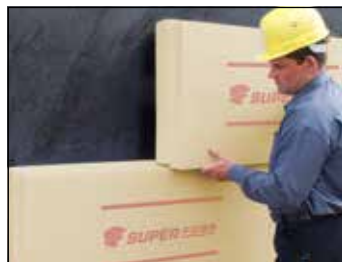
Perimeterdämmung an Kelleraußenwänden
