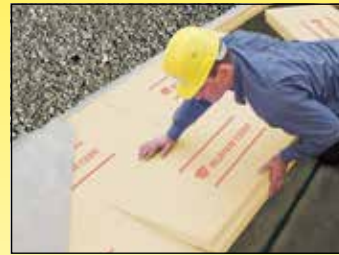
Neubau und Sanierung von Flach- und Umkehrdächern
