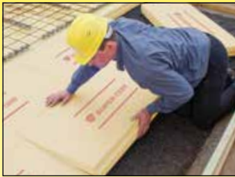
Perimeterdämmung unter lastabtragenden Bodenplatten
