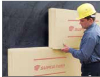
Perimeterdämmung an Kelleraußenwänden
