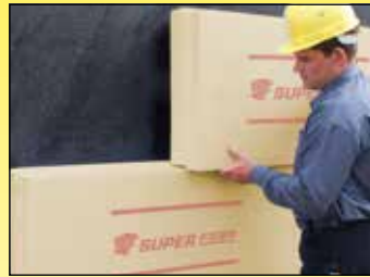
Perimeterdämmung an Kelleraußenwänden
