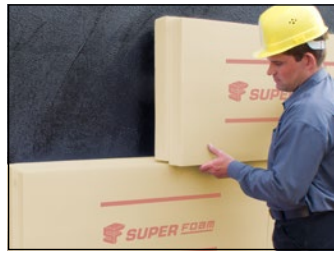
Perimeterdämmung an Kelleraußenwänden
