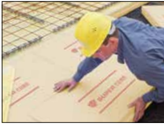
Perimeterdämmung unter lastabtragenden Bodenplatten
