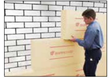
Als Wärmebrückendämmung und im Innenausbau
