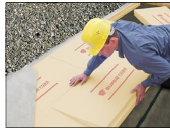
Neubau und Sanierung von Flach- und Umkehrdächern
