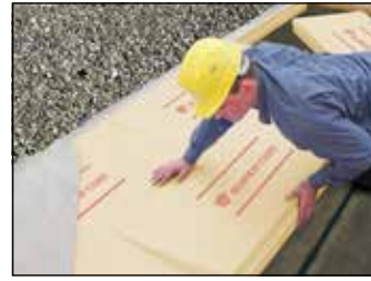
Neubau und Sanierung von Flach- und Umkehrdächern
