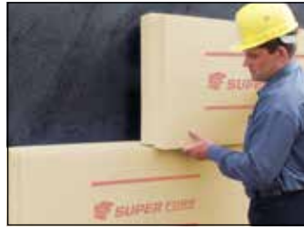
Perimeterdämmung an Kelleraußenwänden
