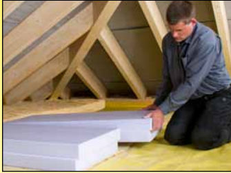
Sanierung der obersten Geschosdecke
