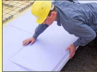
Perimeterdämmung unter lastabtragender Bodenplatte
