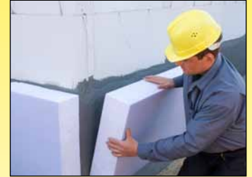
Zweischaliges Mauerwerk (Sockelbereich)
