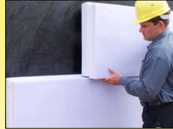
Perimeterdämmung an Außenwänden
