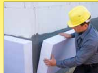
Zweischaliges Mauerwerk (Sockelbereich)
