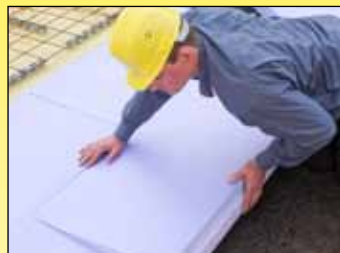
Perimeterdämmung unter lastabtragender Bodenplatte
