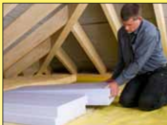
Sanierung der obersten Geschossdecke
