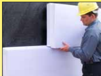
Perimeterdämmung an Außenwänden
